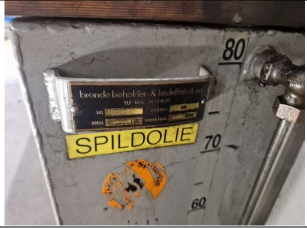
Foto 2 Bordtank til spildolie
