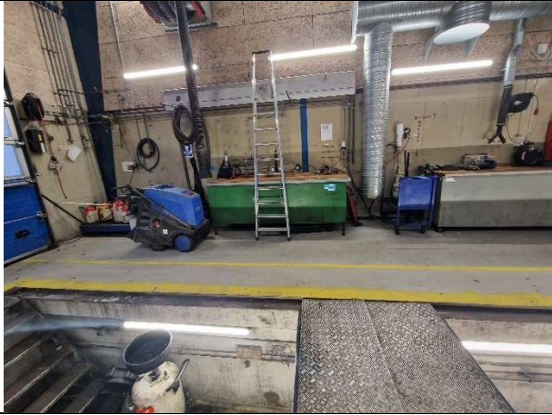
Foto 1 Værkstedsgarage og bordtanke op mod væggen.
