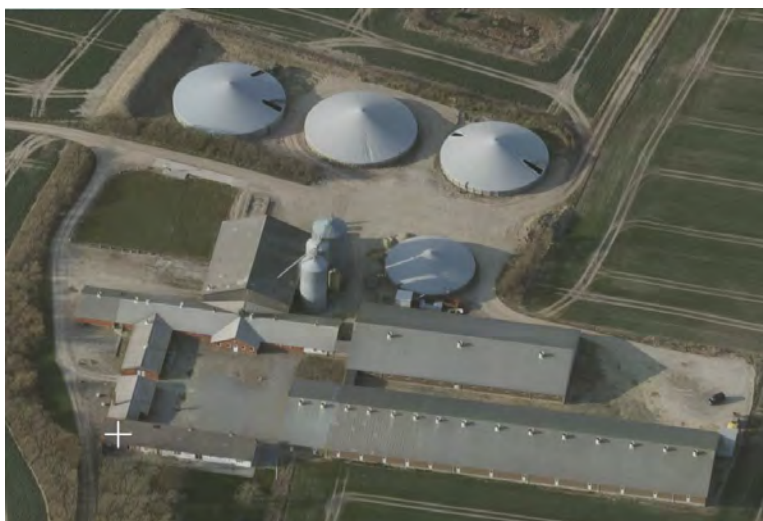
Figur: Oversigt over husdyrbruget, Skærdalvej 4, 7760 Hurup (fra www.skraafoto.dataforsyningen.dk )
