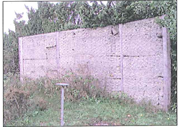
Figur 5: Støjskærm opsat ved standplads.
