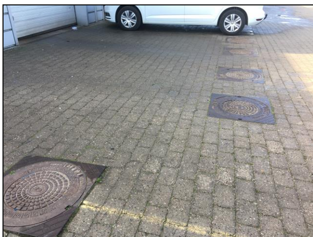
Foto af belægning og olieudskillere foran vaskehal (til venstre) og ved påfyldningsplads (herover).
