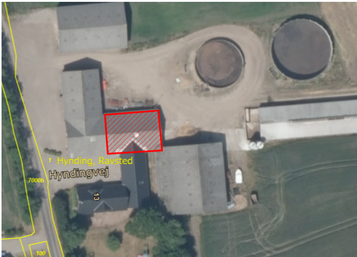
Figur 1. Eksisterende bygningsafsnit med hestebokse på Hyndingvej 13.
