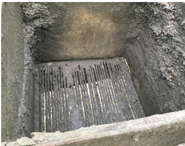
Bundfældningsbassin for rengøringsvand. Spildevandet hældes igennem risten for at frasortere sten.
