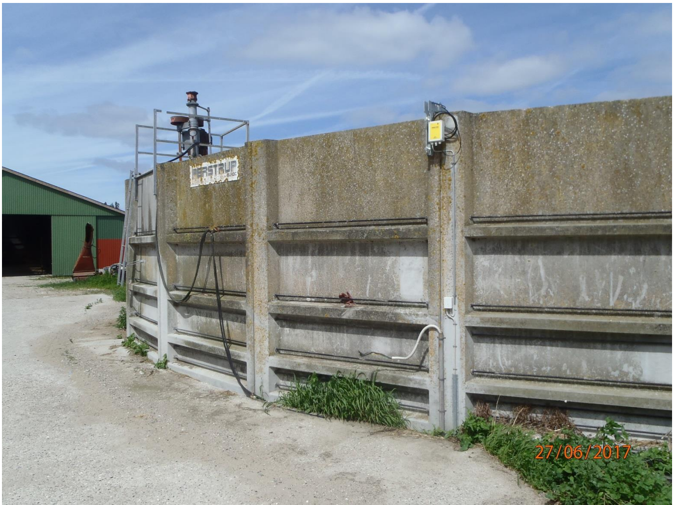
Billedet viser beholderalarm på beholderen på 1530m 3
