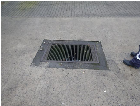
3. Rist med sandfang.
