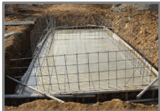
Hærkning af beton
