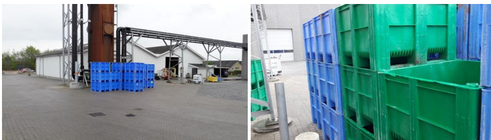
Foto 20 + 21: Tømte, ikke rengjorte kasser med produktrester mellemoplagret ved 80 meter afkast.
