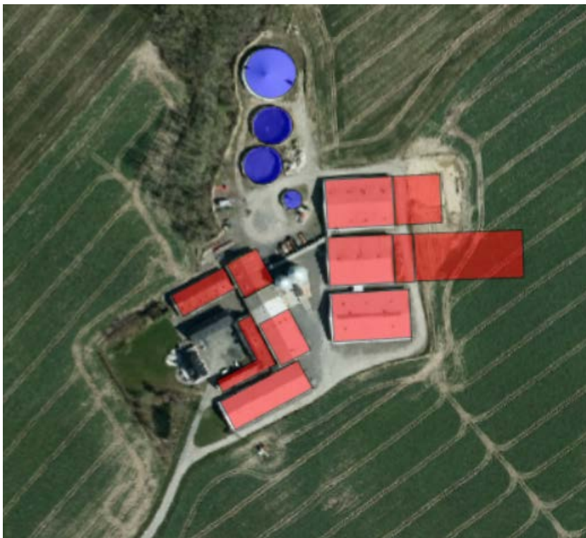
Figur 3 Oversigtskort over hele ejendommen med gyllebeholdere.
