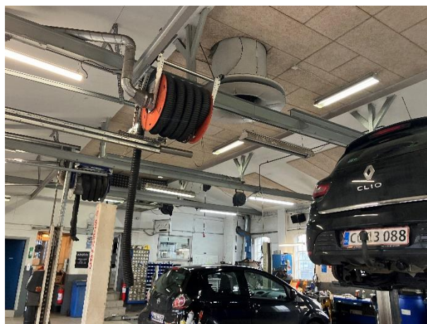
Slangerulle til udstødning, svejserøg m.v., 2023
