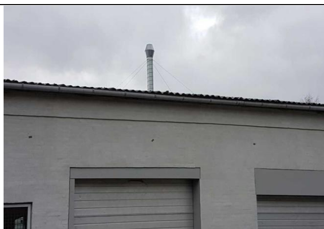
Samlet afkast for udstødningsrøg, svejserøg m.m., 2017
