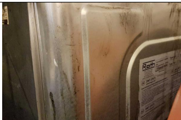
Spildolietank (dobbeltvægget) af mærket Roth, 2017
