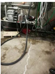
Billede 1 Spild af kemikalier på gulv ved tappemaskine.
