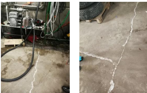
Billede 6. Reparation af revner i gulvbelægning i tapperum med sika bitumenmasse.
