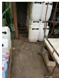
Lagerrum med afløb
