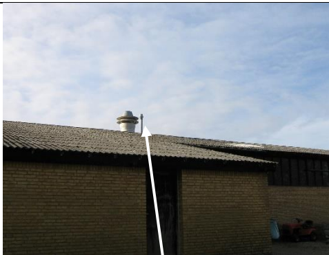
Billede nr. 2: Afkast fra udstødning (2014). Det store er rumventilation.
