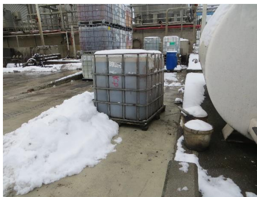
Palletank spærrer for tankning over beton. Spild af diesel på asfalt for enden af tanken
