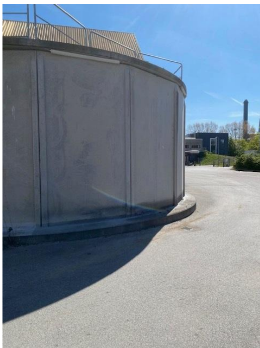
Til udendørs lagertank (bemærk vejriste til regnvandssystem)
