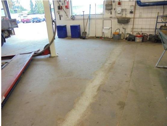
Afløb i det gamle værksted er sløjftet (støbt til)
