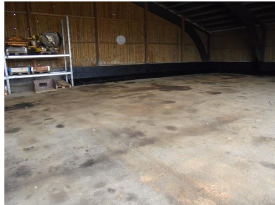
Den nye salt-bygning hvor halvdelen af soklen pt. er behandlet med et beskyttende lag.
