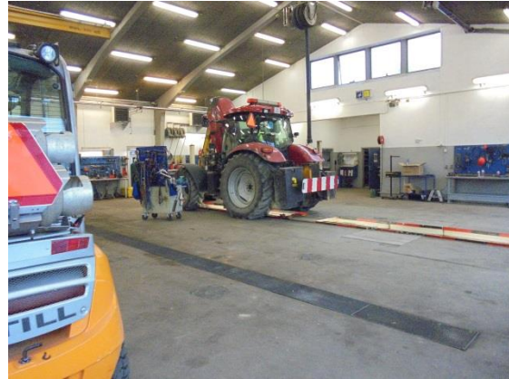
Afløb i gulvet i det nye værksted
