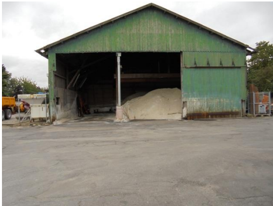
Den eksisterende salt-bygning, der skal nedrives
