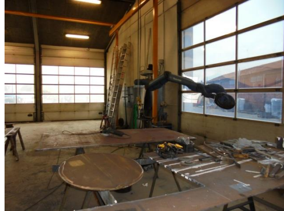
Svejsesudsugning i smedeværkstedet
