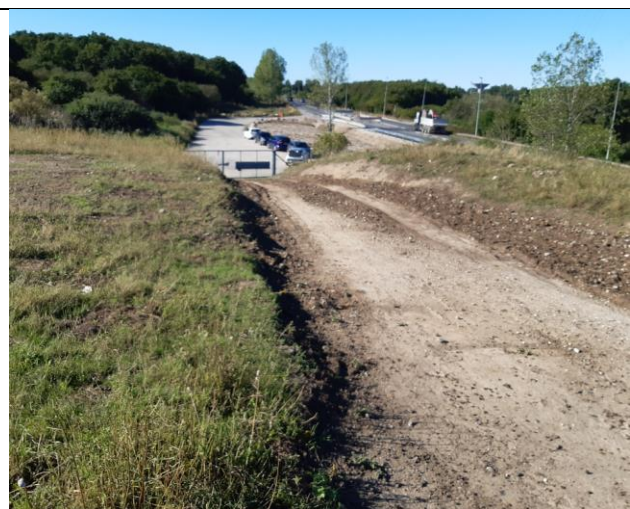
Fig. 4 Kig mod indkørslen i syd. Under arbejdet med slutafdekkning var der etableret en midlertidig grusrampe på det stejle stykke i indkørslen. Denne var bortfjernet.
