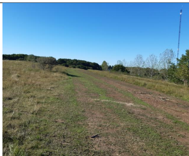
Fig. 3 Kig mod syd. Under slutafdekkningen var der etableret kørevej hen over det gamle og tidligere slutafdekkede areal. Kørslen så ikke ud til at have medført skader.
