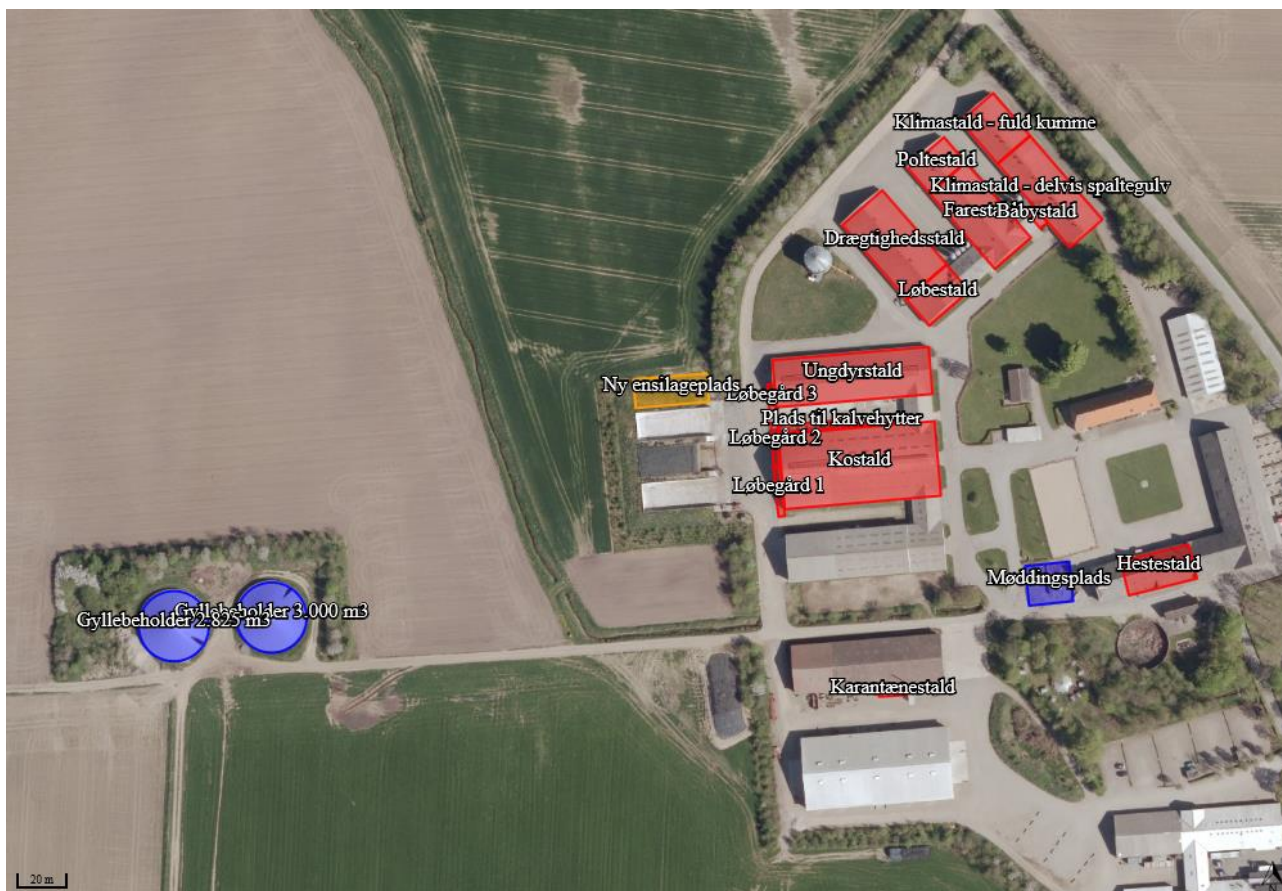
Figur 1: Husdyrbrugets stalde og opbevaringsanlæg. Foto: husdyrgodkendelse.dk
