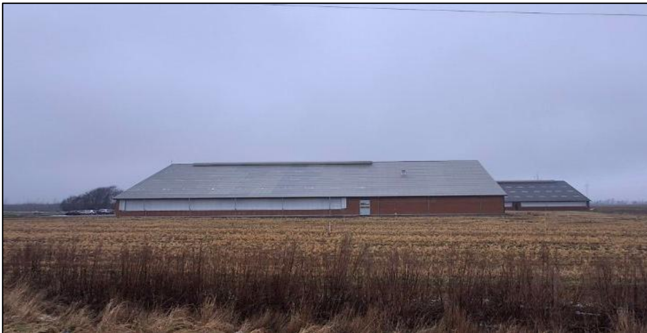
Figur 4. Sydvendt facade af eksisterende velfærdsstald med malkecenter (bygning 23). Foto fra ansøger.
