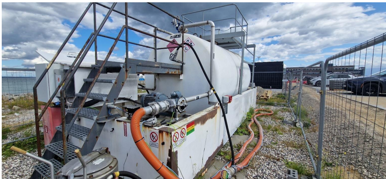
Olietank til jetfuel, som er opstillet i et kar.
