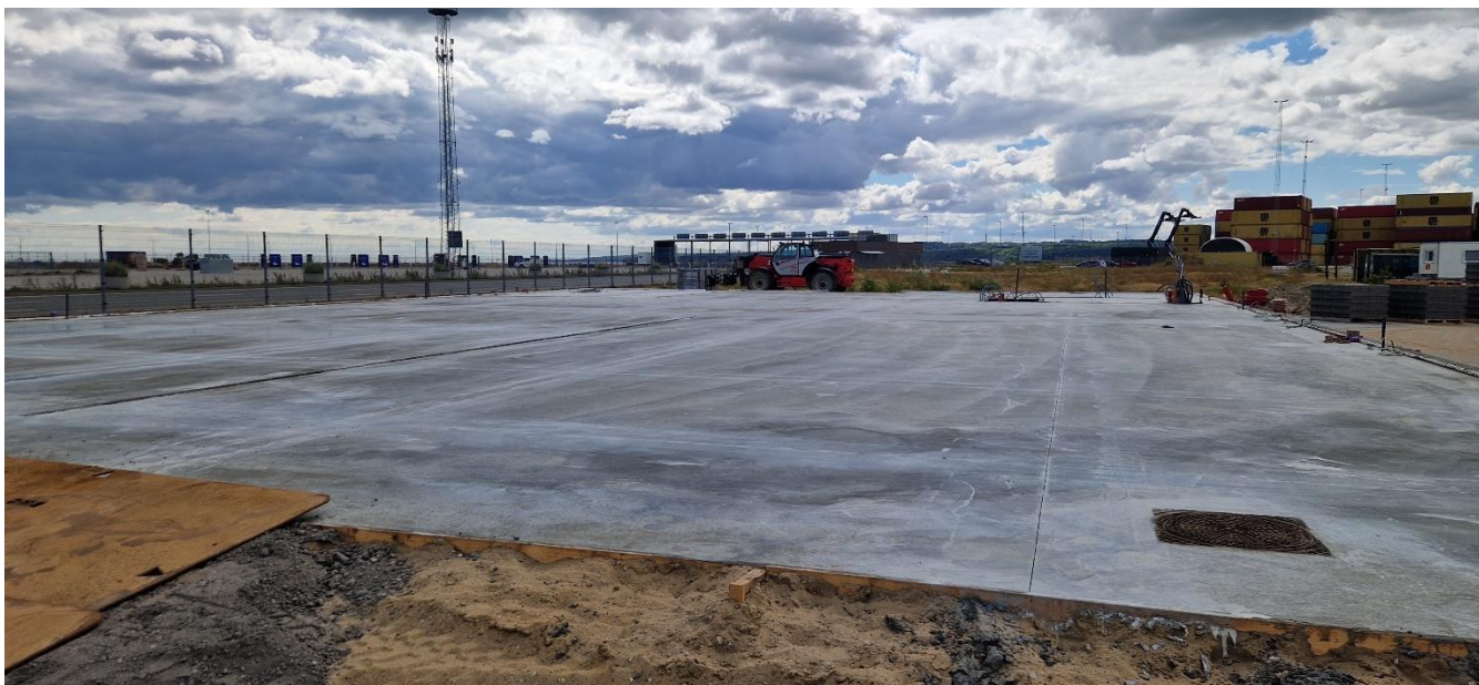
Ny hangar under opførelse.
