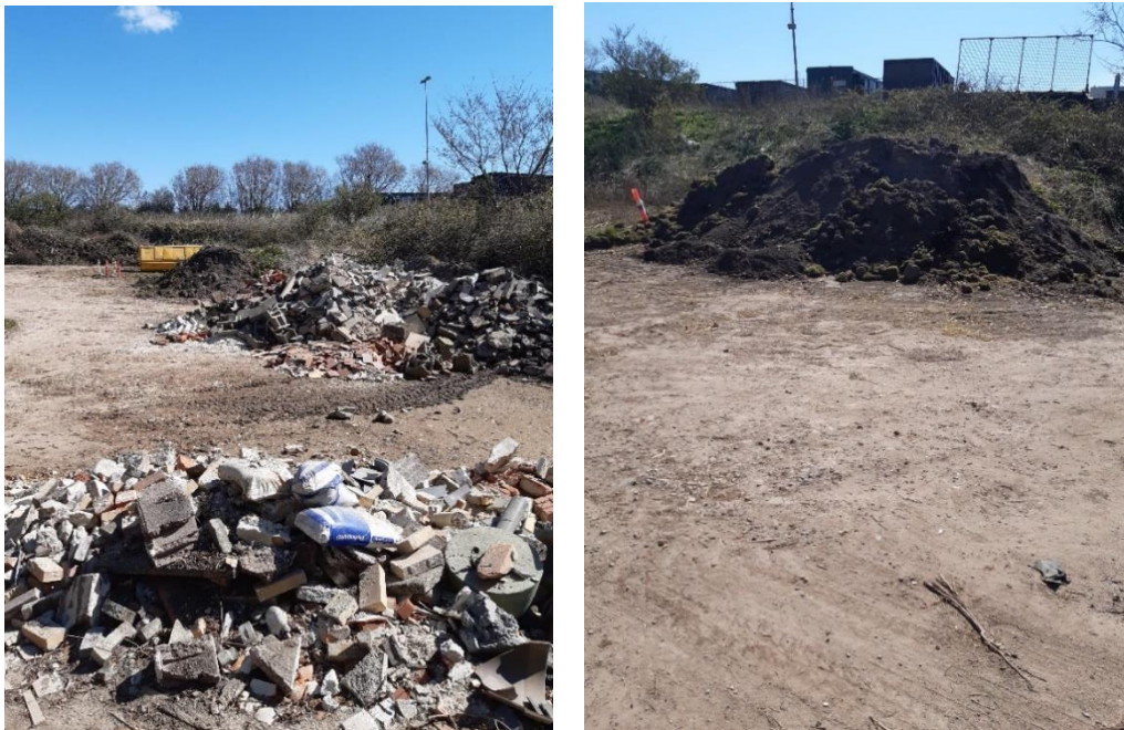
Figur 3 tv. Oplæg af beton og tegl. den nederste bunke skal sorteres for andet affald, før det tilføres den større bunke med beton og tegl. th. Oplæg af jord.
