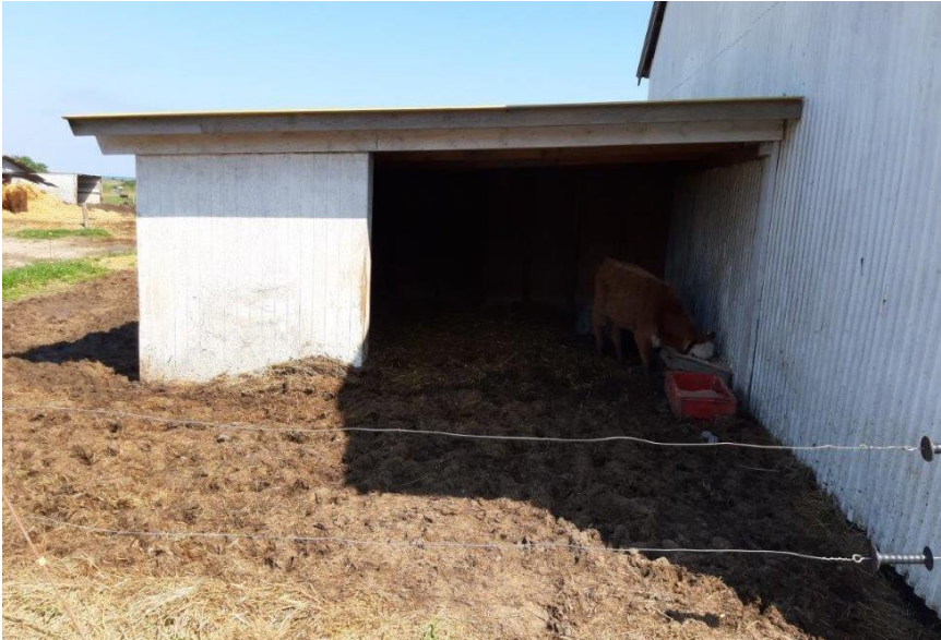
Foto 1. Husdyranlæg op ad maskinhal skal udvides og eksisterende læskure nedlægges.
