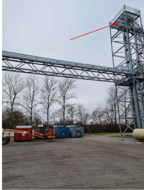
24. Trækstation (motor) US silo
