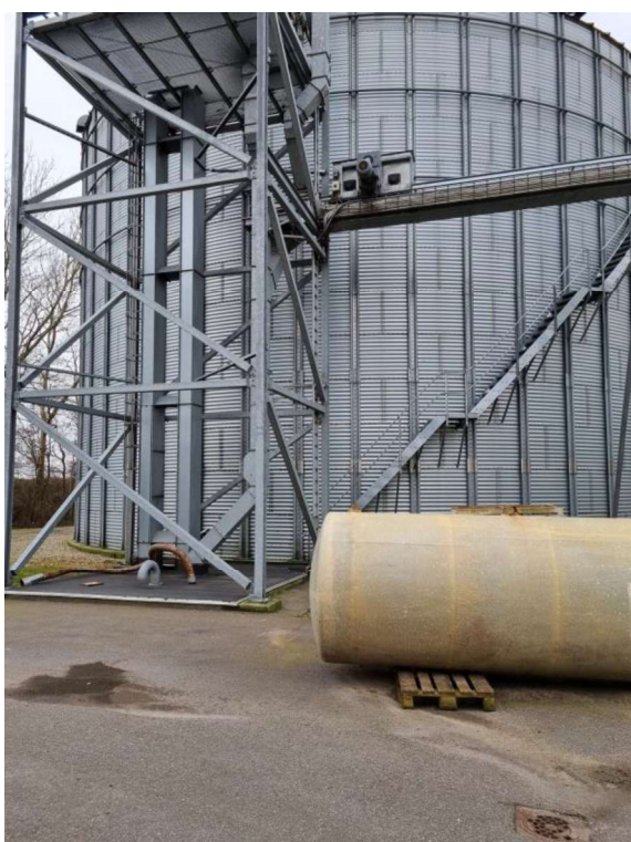
22. Faldrør ved US silo
