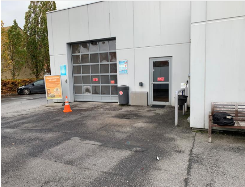
Foto af belægning på forvaskepladsen
