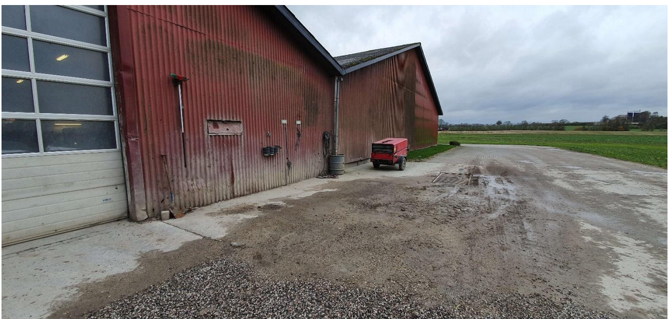
Udendørs vaskeplads med afledning til dræn/vandløb via olieudskiller.
