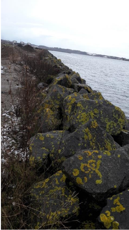
Dige langs nordlige side af deponiet.
