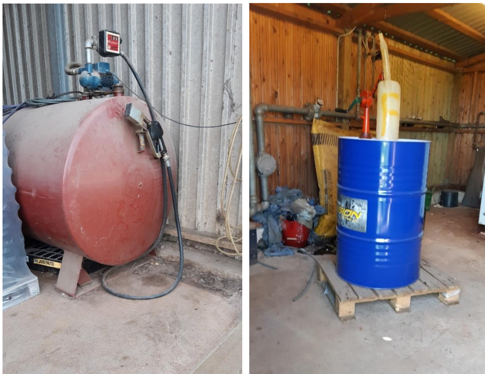
Figur 12. Oplag af oliestoffer. Tv: Olietank lige indenfor porten til garagen. Den mobile spildbakke ses skubbet ind under tanken. Th: tromle med olie i gashuset.
