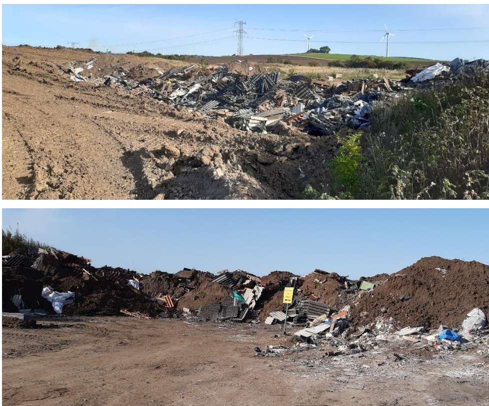
Figur 2. Uafdækket asbestaffald på etape 6. Øverst: Asbestaffaldet set fra bagsiden af tippet. Nederst: Asbestaffaldet set fra tippet.
