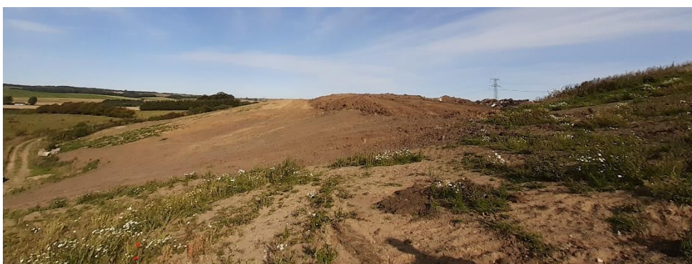
Figur 3. Slutafdækning. Øverst: Slutafdækningen på etape 5A. Nederst: Udsigt fra etape 5A ud over etape 5B. Terrænet skåner ned mod kørevejen.
