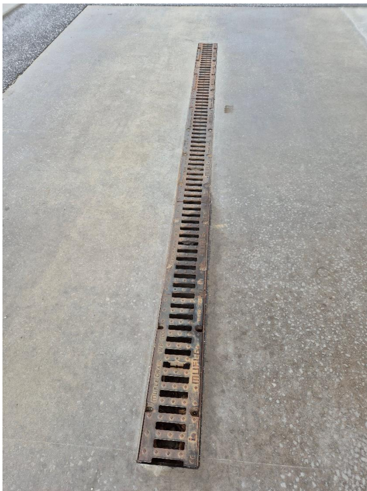
Figur 6. Liniedræn med sandfang.
