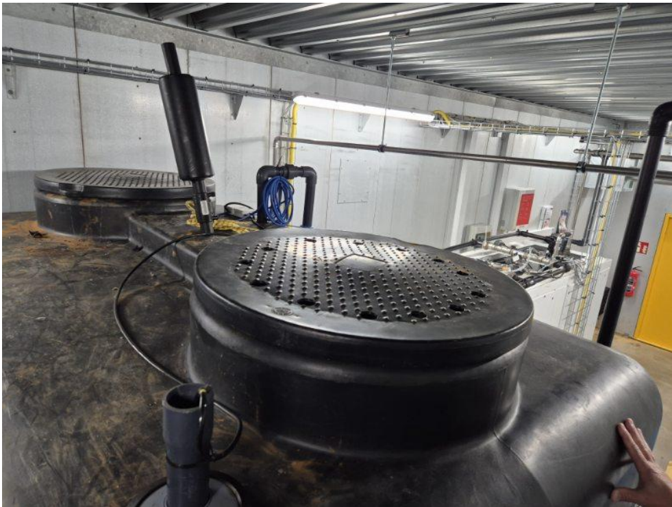
Figur 2. Lokalt mini-renselanlæg til genanvendelse af vand i vaskehal. Det vand der ikke genanvendes ledes til olieudskiller og derefter offentligt renselanlæg. Om vinteren er genanvendelsesgraden lavere, da der er meget salt i vandet efter bilvask.
