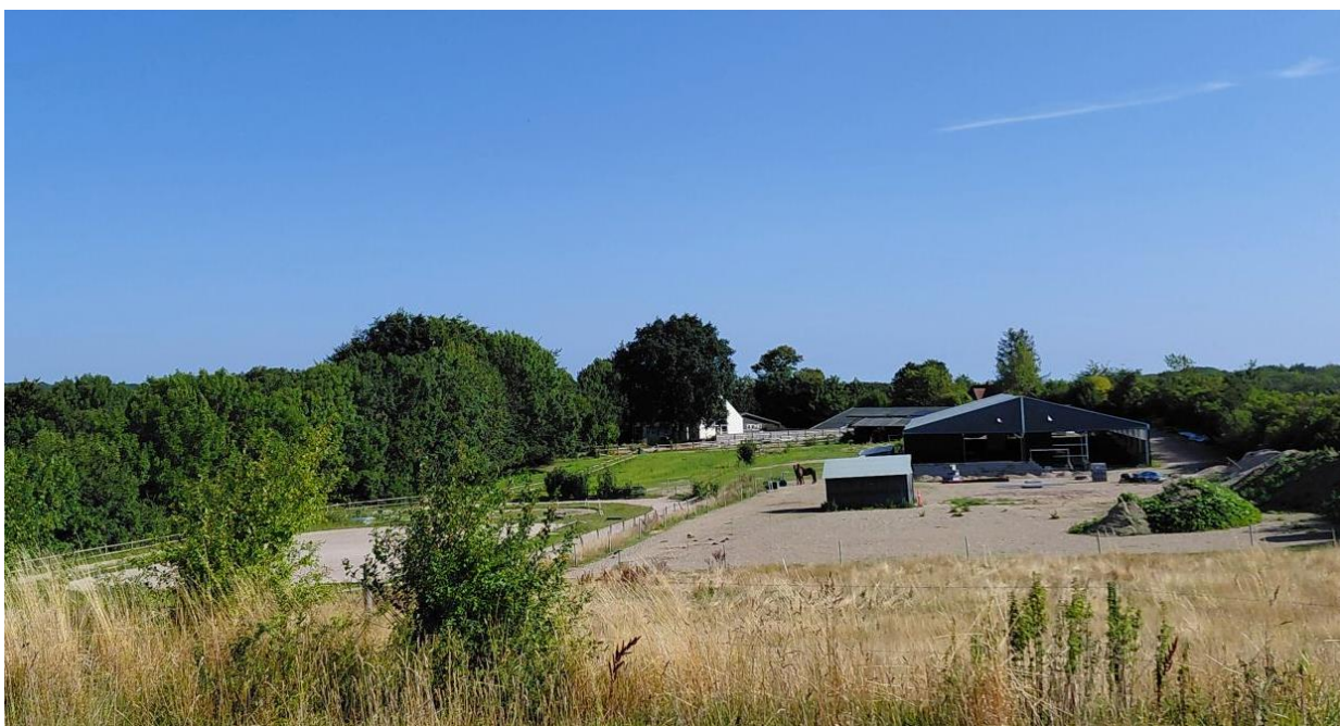
Foto 2025, set fra syd. Bagest til højre den allerede opførte 20 x 45 m hal (bagerst på hallen, ude af syne, på den nordlige del af bygningen ansøges om yderligere 5 m forlængelse af bygningen. Midt i fotoet ses et flytbart læskur, til venstre den nuværende ridebane.
