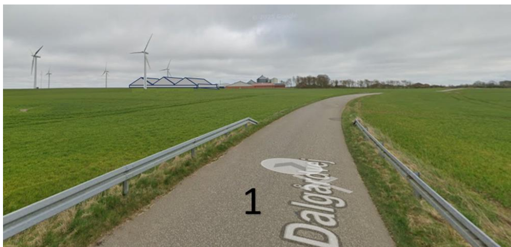
Byggeriet set fra sydøst, hvorfra byggeriet stort set er gemt bag de eksisterende bygninger:
