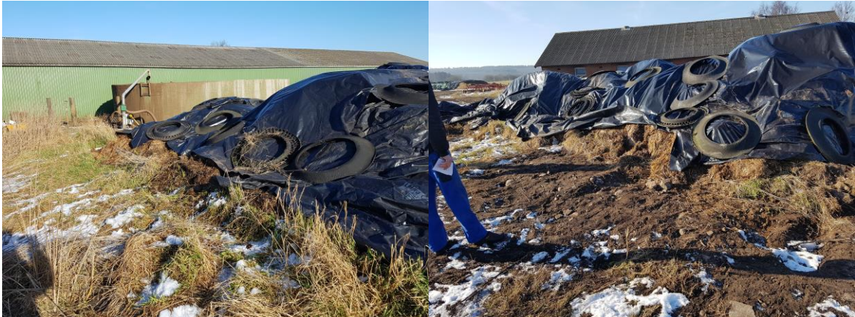
Billede 2: Øst og vest for møddingspladsen væltede faste gødning ud over kanten.
