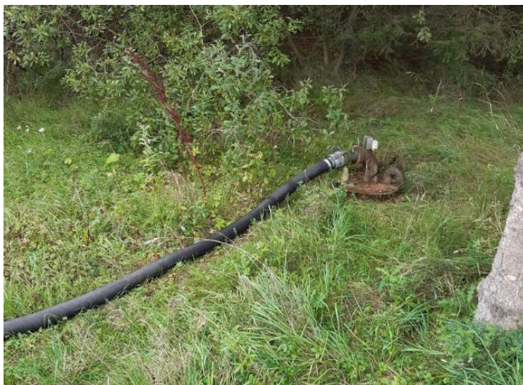
1. Pumpeledning til tømning af perkolatbeholder.
