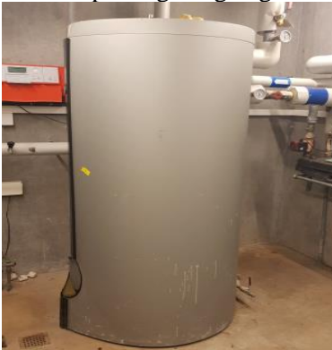
Varmtvandsbeholder.
