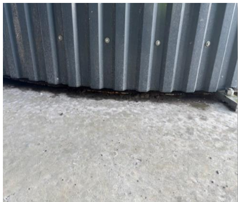
Figur 13: Utætheder fremgår ved at vandet kommer ud mellem betonfundamentet og bundringen. Bunden af tank B kan inspiceres igennem en mandeluge.
