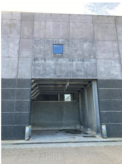
Figur 6: Udliveringsboks med humus. Mellem humusboksen og afløbsrende er der støbt beton. Betonen går 1 meter ud på den anden side af afløbsrenden.
