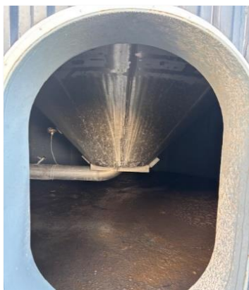
Figur 13: Utætheder fremgår ved at vandet kommer ud mellem betonfundamentet og bundringen. Bunden af tank B kan inspiceres igennem en mandeluge.
