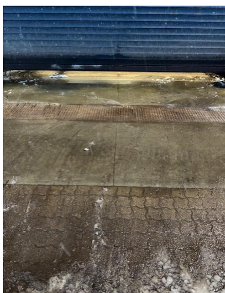
Figur 6: Udliveringsboks med humus. Mellem humusboksen og afløbsrende er der støbt beton. Betonen går 1 meter ud på den anden side af afløbsrenden.
