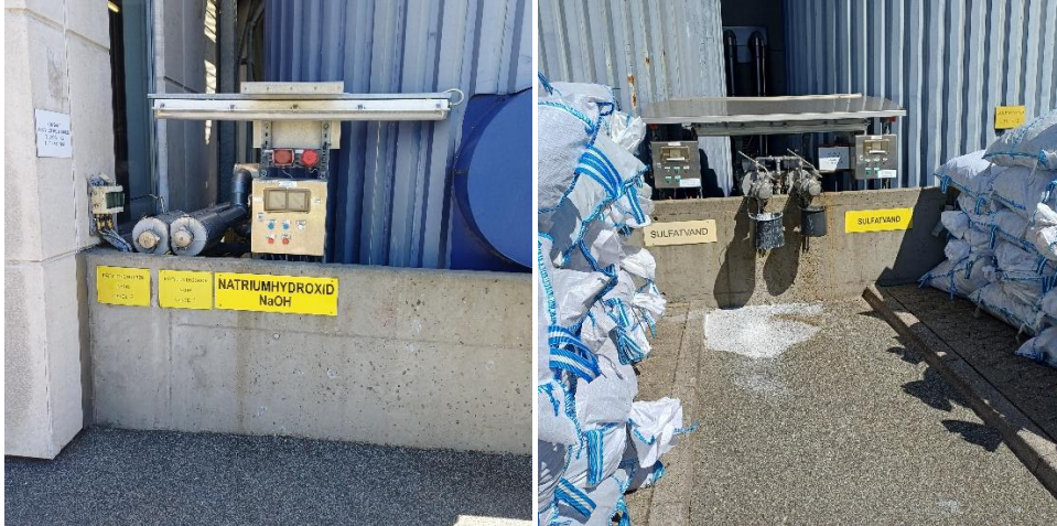
Tv.: To tanke til NaOH. Th.: To tanke til sulfatvand.
