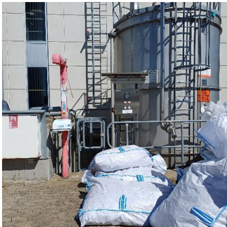
Tank til hydrogenperoxid (brintoverilte.)
