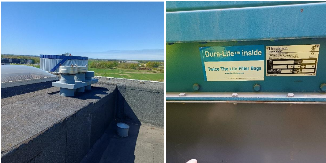
TV.: Afkast fra filteret på askesiloen (på taget). TH.: filteret på askesiloen.
