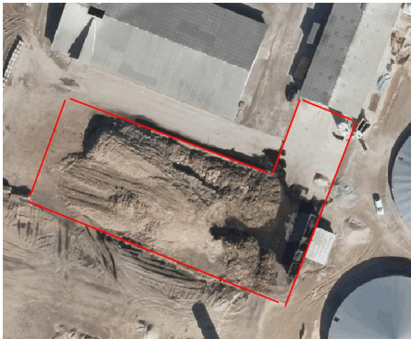
Billede nr. 7: Det indrammede område er belagt med asfalt. Arealet ind mod stalden er betonfunderet.
