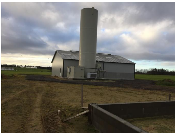
Billede nr. 1: Ny bygning til gaslager samt nyt afsvovningsanlæg
