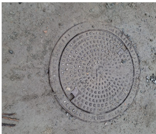
Foto 14. Dæksel til grundvandsmoniteringsboring OBS6
