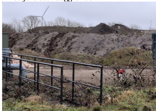
Foto 21. Biaktivitet med mikrobiologiskbehandling af jord. Miler med jord ses i baggrunden.
