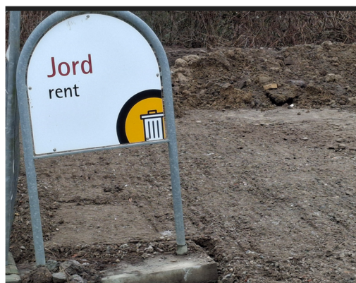
Foto 10. Skiltning af oplag af ren jord til daglig afdækning/slutafdekning
