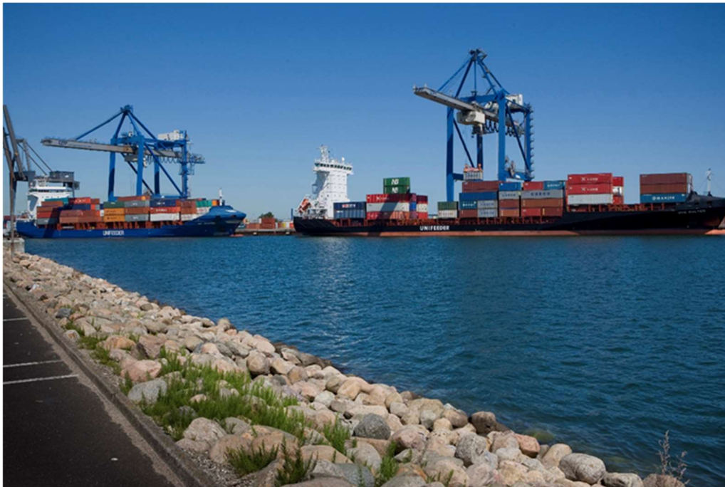
Figur 3: Eksempel på STS-kraner. Her fra den eksisterende containerterminal på Levantkaj i Nordhavn.
