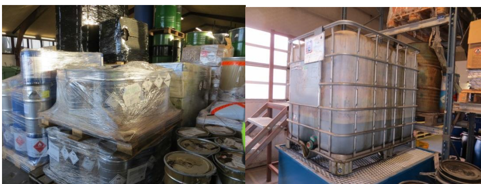
Oplag i lagerhallen på den "gamle lagerplads" tank til spildolie er kommet op på en spildbakke.
