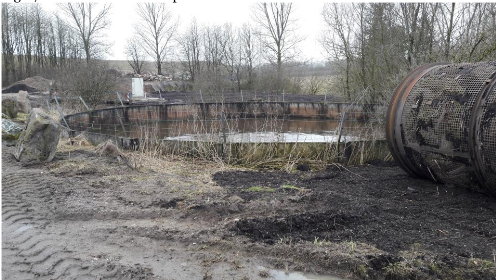
Fig. 18. Perkolatbassin før trykledning til renseanlæg
