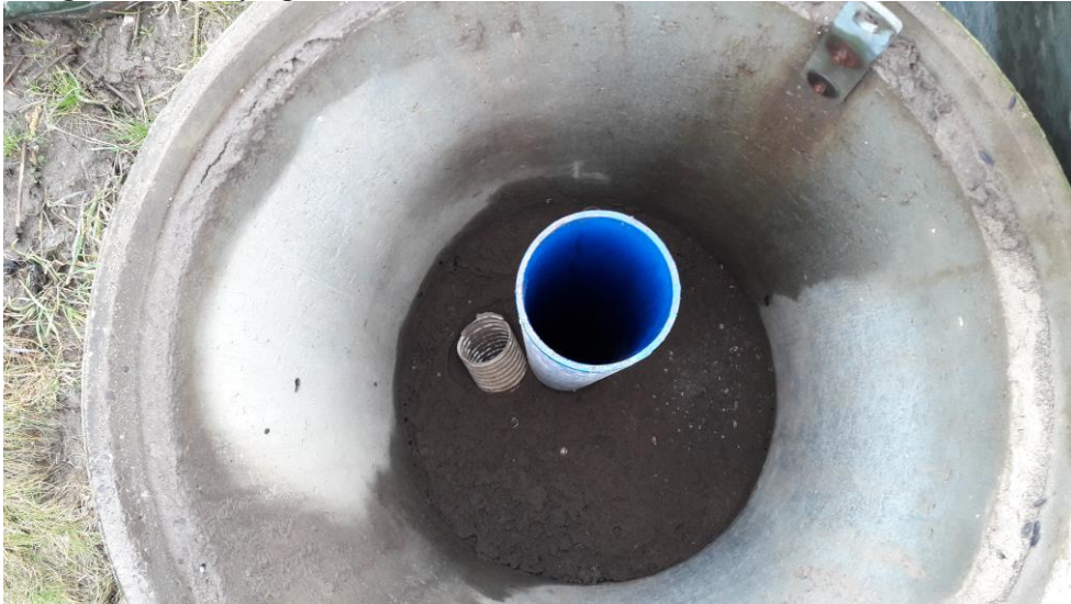
Fig. 21. Kontrollboring B1. Forerøret skal afproppes med låg.
