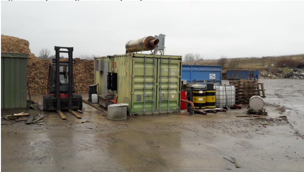
Fig. 13 Gasmotorcontainer på genbrugsplads.
