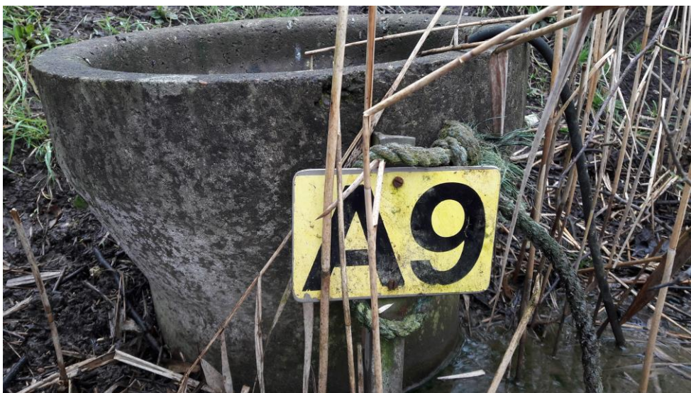
Fig. 10. Brønd A9. Tæthedskontrol for rodzoneanlæggets membran
