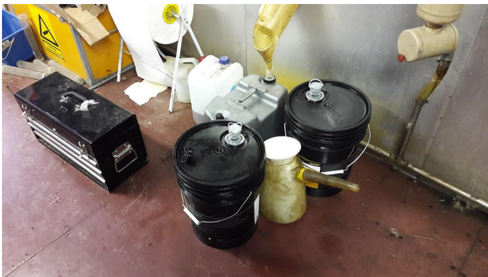
Fig 15. Oplag af olie i gasopsamlingscontainer på deponiet.
