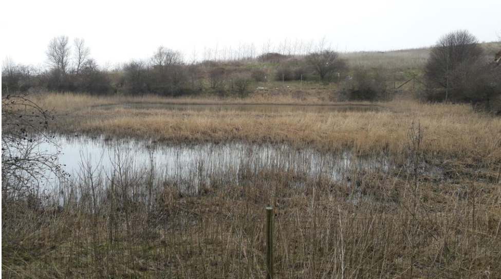
Fig. 9. Rodzoneanlæg til forrensning af perkolat før det ledes til renseanlæg.
