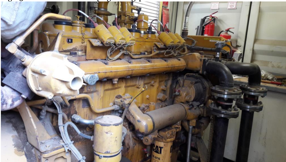
Fig. 14 Gasmotor på genbrugsplads.
