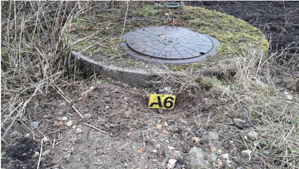
Fig. 17. Kontroldræn A6 ved perkolat bassin.
