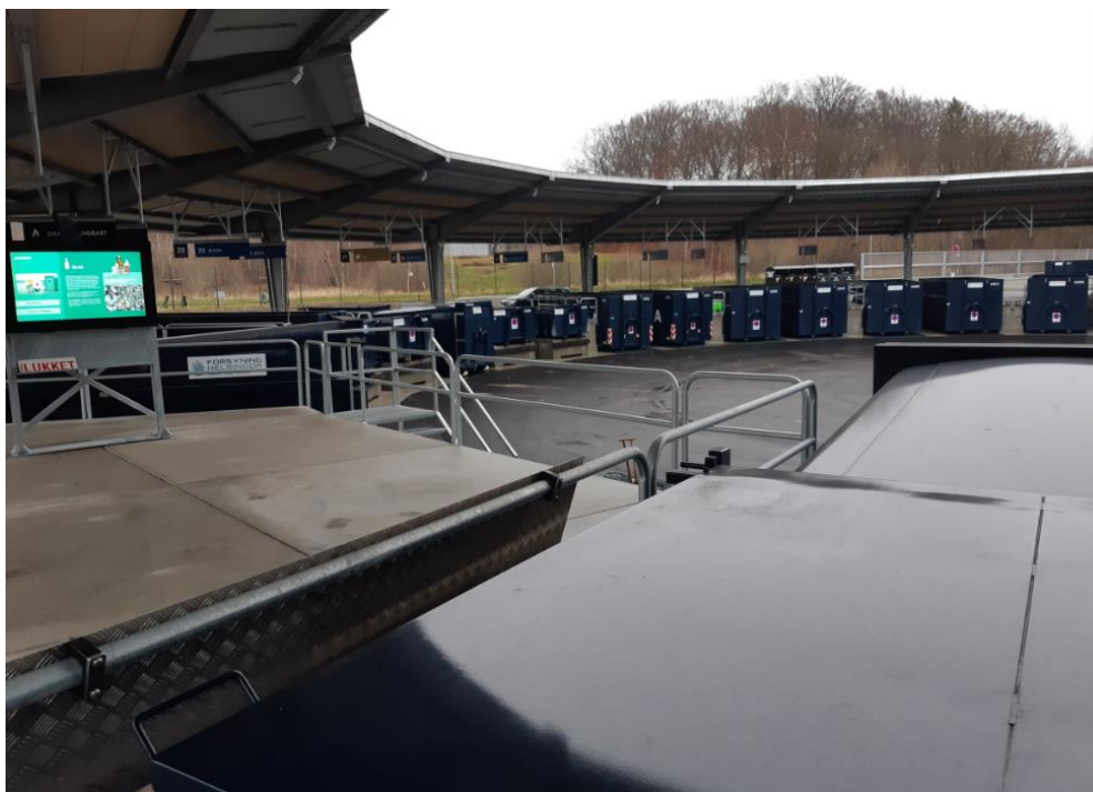
Containergård under cirkelformet halvtag
