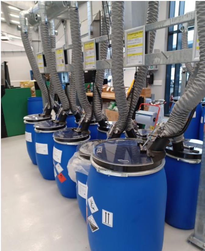
Kemibygning – tromler med individuel udsugning
