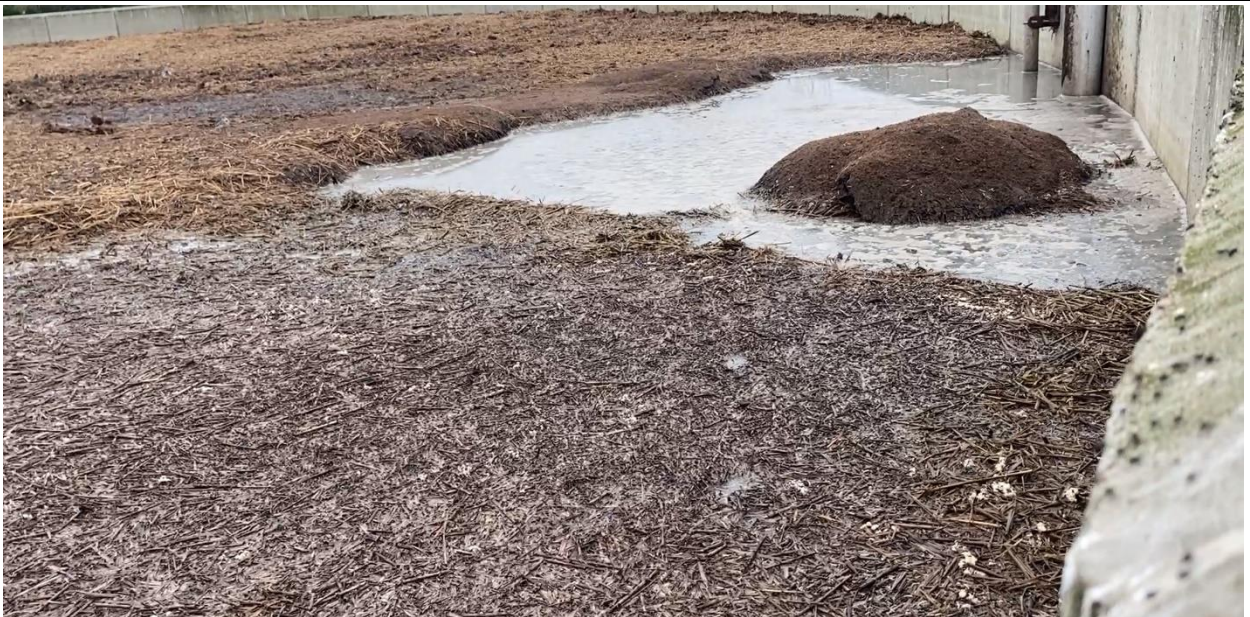
Gyllebeholder, dykket indløb
