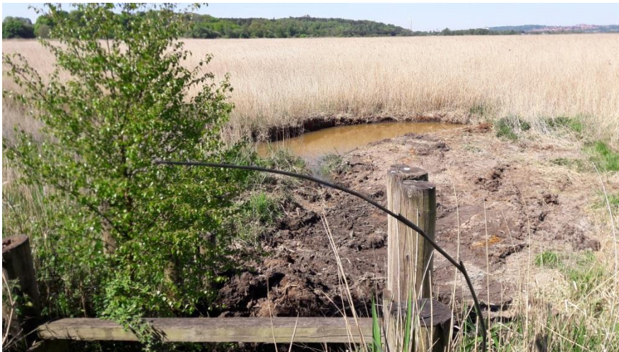
Foto 3. Jordvold foran sluse i nordøstlige hjørne.
