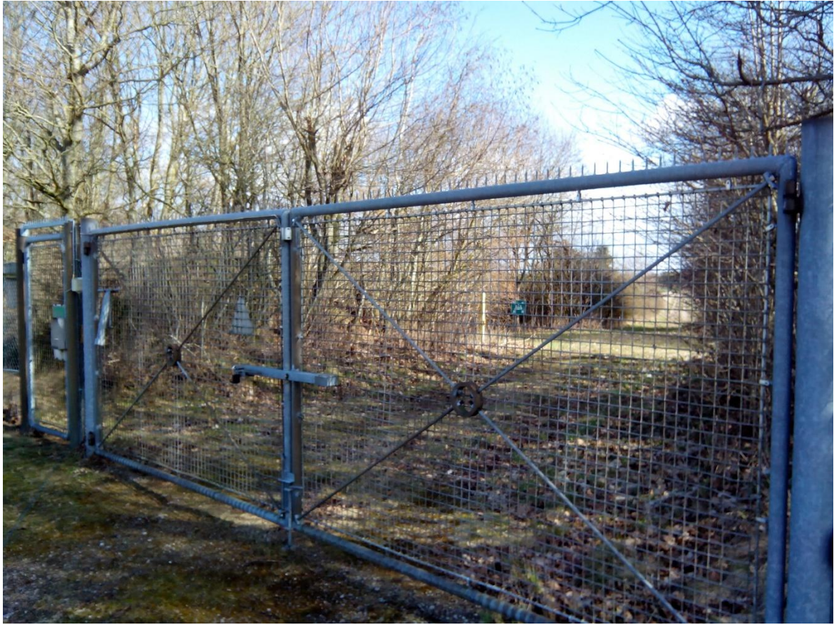
Foto af udgang til mønstringsplads nord for virksomheden (rød pil tidligere/ovenstående foto).
