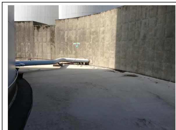
Belægningen i lille tankgård
