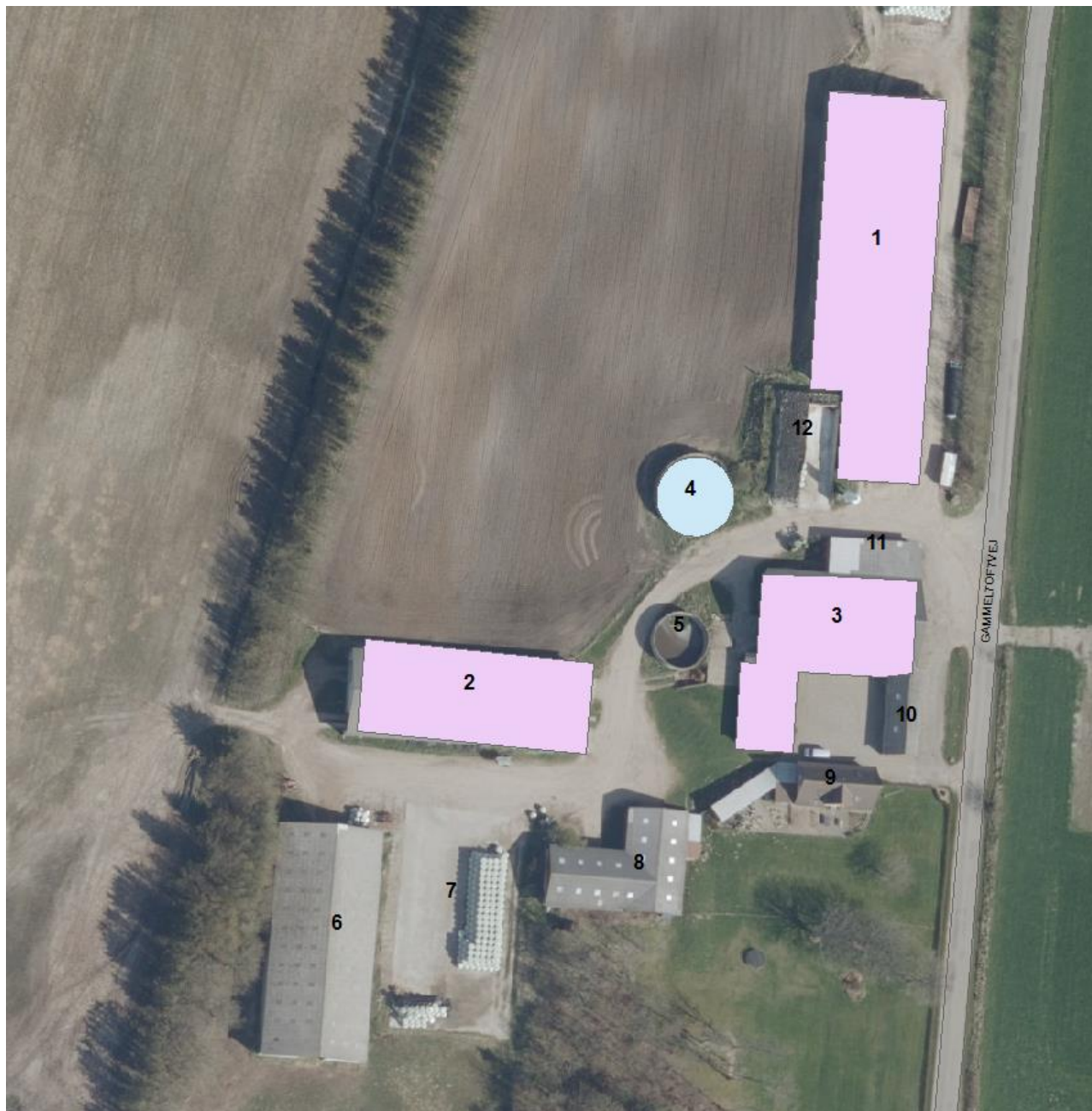
Figur 1. Oversigt over husdyrbrugets bygninger.
