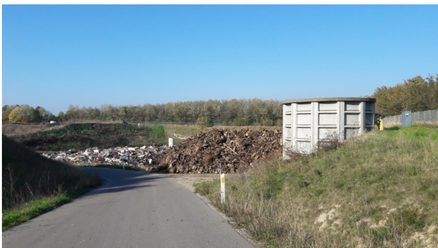
Oplag af træstød syd for Etape 4.2.2 og perkolatpumpebrønden til renseanlæg. AffaldPlus oplyste, at der er en serviceaftale mht. perkolatpumperne.
