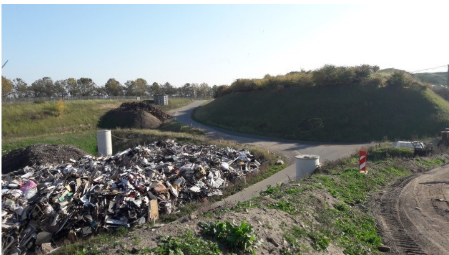
Oplag af 1.220 t brændbart, imprægneret træ, rent træ, træstød og haveaffald på Etape 4.2.2 (sorter- og omlastepladsen), der er beliggende ovenpå anlæggets sidste, tomme deponeringsenhed og har belægning med SF-sten. Der er termisk overvågning mhp. brandforebyggelse.
