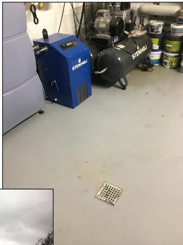
Foto herover af teknikrum, hvor kompressor er placeret. Afløb leder til olieudskiller.
