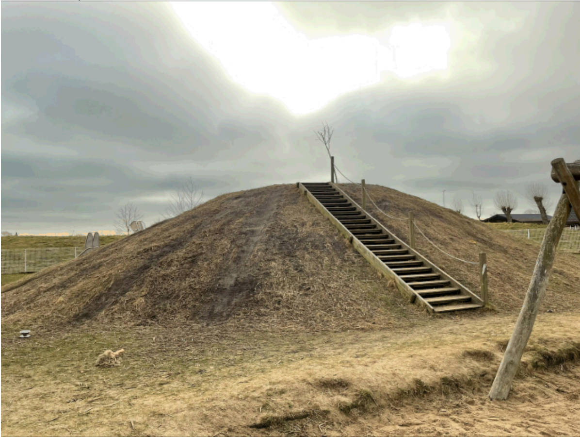
Figur 1. Bakken på legepladsen. Slaggekernen er dækket af med 50 cm ren jord og øverst ses gummimåtterne som forhindrer at der lige så stille via slid og vejr kan opstå risiko for kontakt med slaggen.
